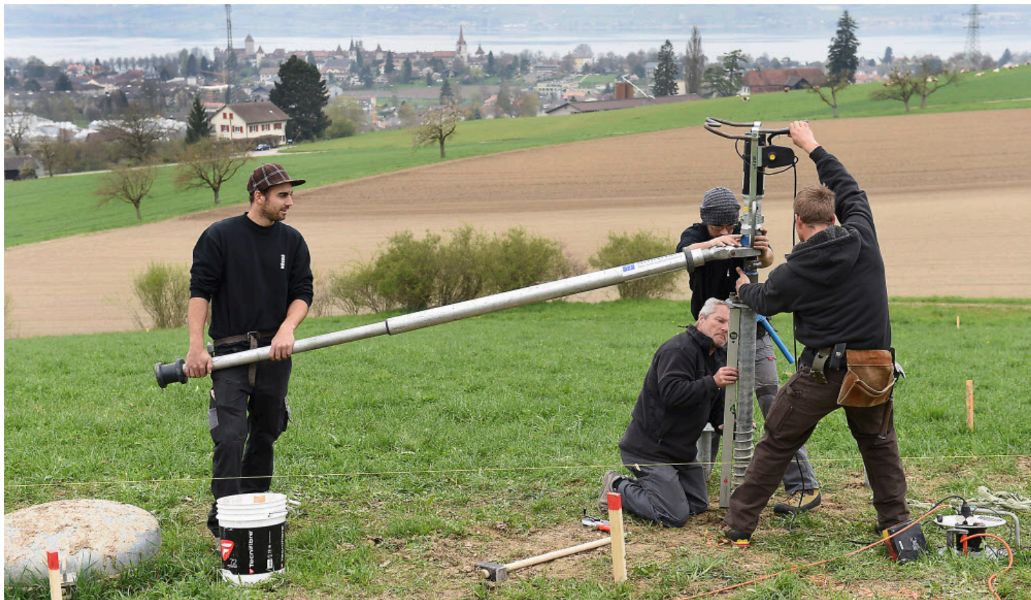
Das Team um Projektleiter Tom Iseli (kniend) bohrt die ersten Verankerungen für die Tribüne in den Boden.
