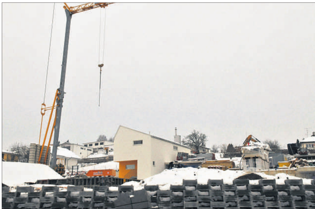
Das Bauland in der Gemeinde Courgevaux schwindet dahin.
